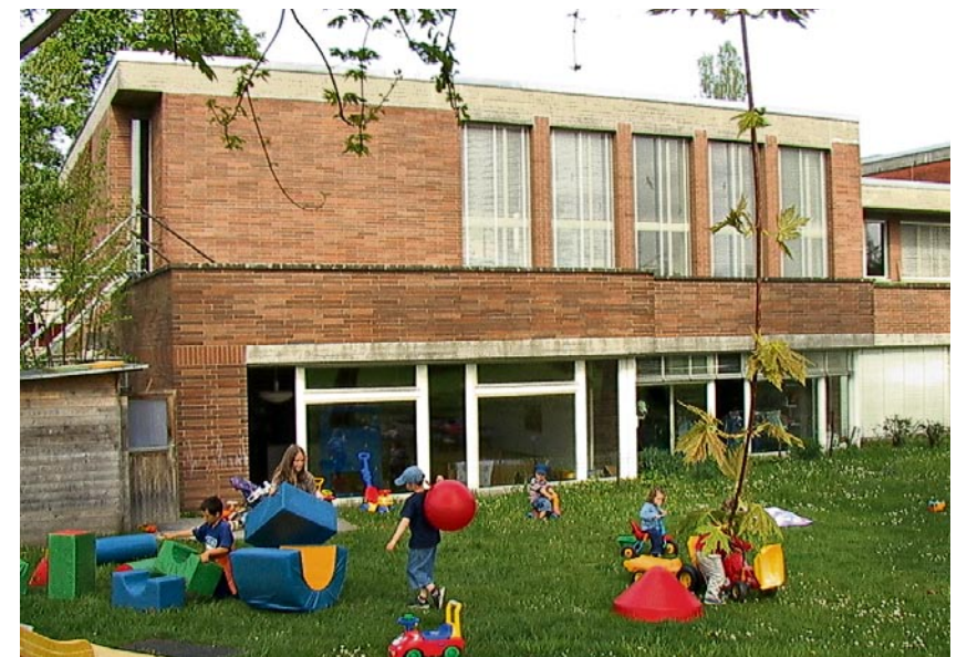
MüZe vor der Sanierung 2006. Sichtbar ist die markante Klinkerbauweise.
