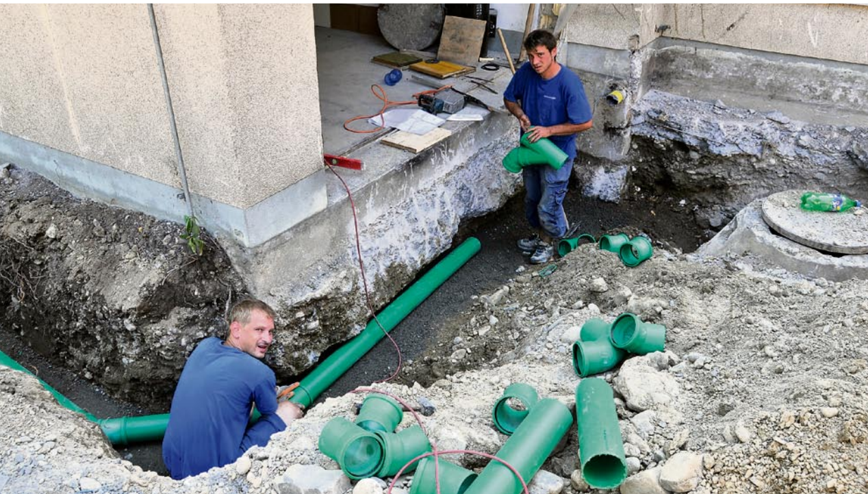
Die Totalsanierung des Kirchgemeindehauses läuft weitgehend nach Plan. Hier werden die rings um das Gebäude verlaufenden Regenwasserableitungen verlegt.
