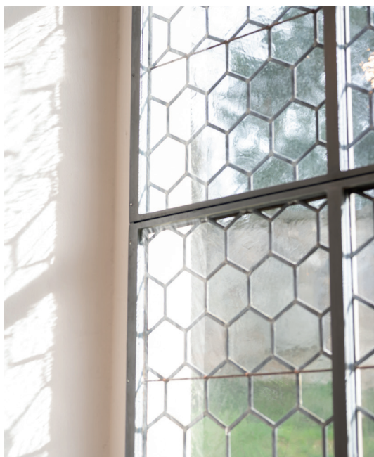
Fenster in der Kirche Muri Thunstrasse 115, 3074 Muri
